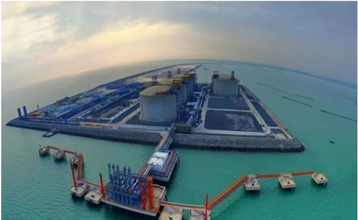
图 4-2 国家管网北海 LNG 码头
